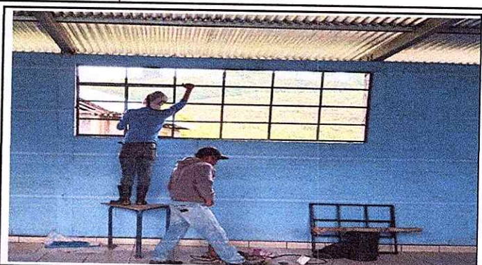
Foto 2: SE EVIDENCIA LA INSTALACION DE LA VENTANA DE METAL
