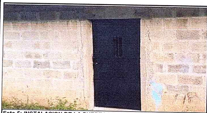
Foto 5: INSTALACION DE LA PUERTA DE METAL
