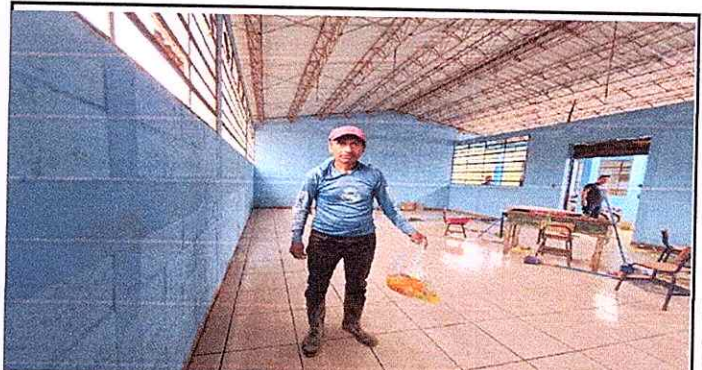
Foto 4: SE OBSERVA LA INSTALACION DE PISO CERAMICO EN ESTA AULA.
